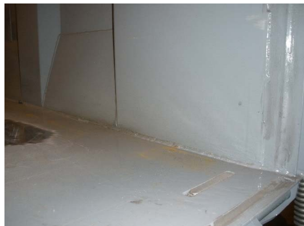
Schweißnähte Innenseite auf Risse prüfen
