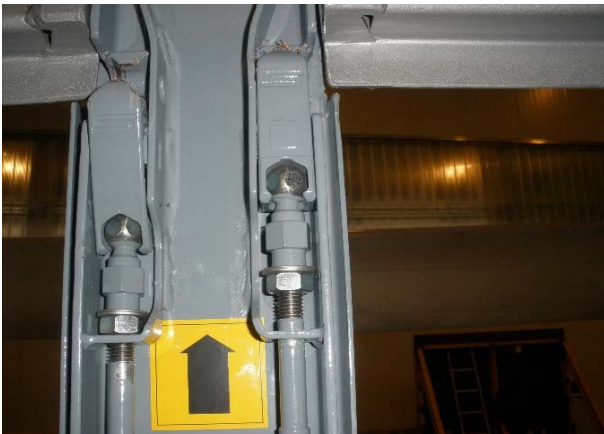
Verriegelung Pendelbolzen auf Spiel und Funktion
