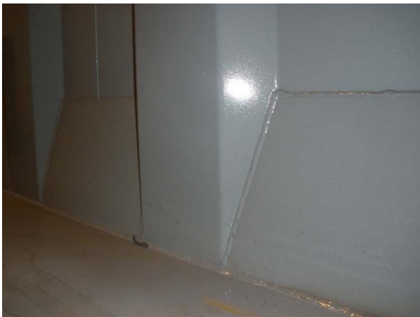
Schweißnähte Versteifungen Innenseite
