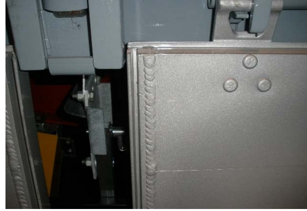
Bordwände: Schweißnähte auf Risse prüfen
