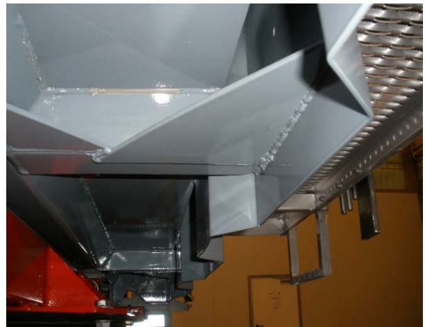
Schweißnähte auf Risse prüfen
