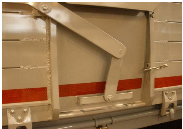
Rückwand: Schweißnähte auf Risse prüfen
