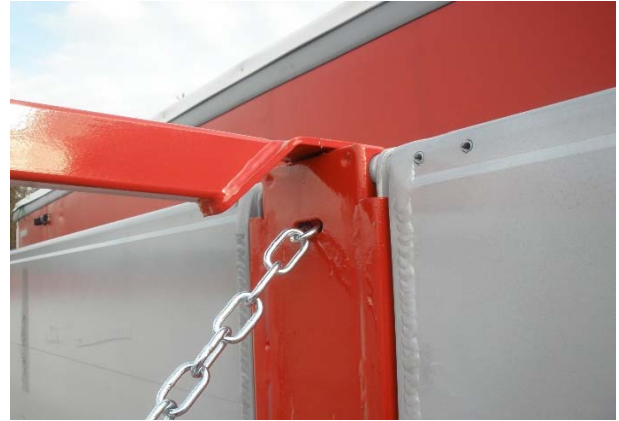
allgemeine Sichtprüfung der Mittelrungenverbindung, bzw. Kettenverbindung
