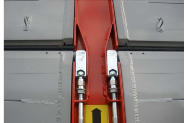
Bordwände: Schweißnähte innen und aussen auf Risse prüfen
