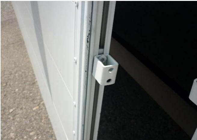
Gegenhalter auf Festsitz und Beschädigung prüfen
