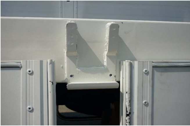
Rungenlager: Schweißnähte auf Risse prüfen
