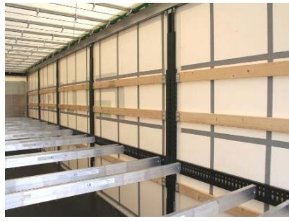
Seitenplane: Schweißnähte der Gurtverstärkungen auf Risse und Beschädigungen prüfen
