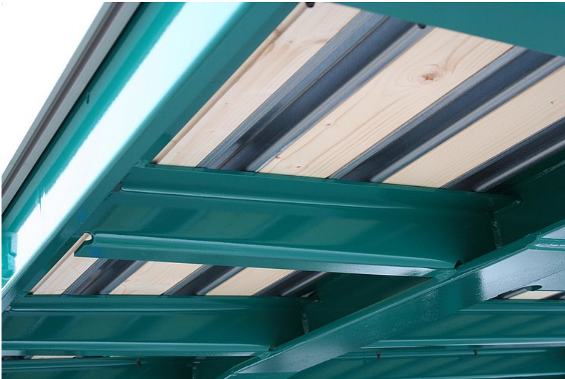
Doppelboden bestehend aus Stammboden mit integrierten Stahl-Omeegaschienen und darüber mit Siebdruck-Verschleißboden (Staplerachslast 7 t)
