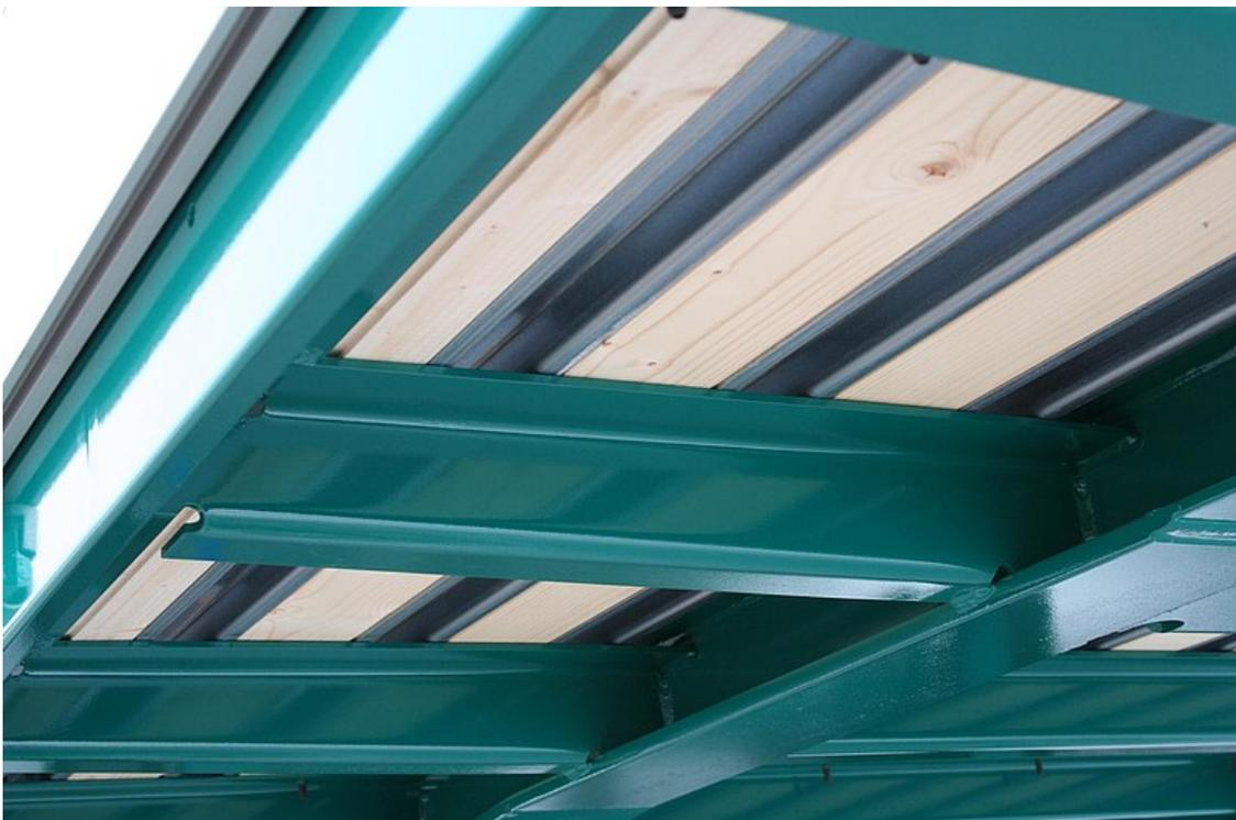
Doppelboden bestehend aus Stammboden mit integrierten Stahl-Omeegaschienen und darüber mit Siebdruck-Verschleißboden
