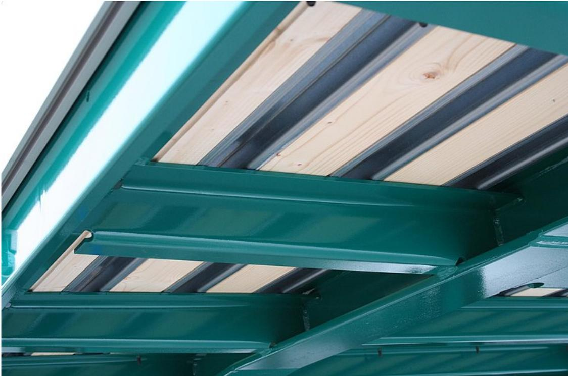
Doppelboden bestehend aus Stammboden mit integrierten Stahl-Omeegaschienen und darüber Siebdruck-Verschleißboden (Staplerachslast 5.460 kg)
