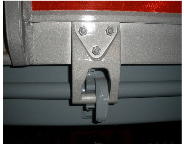
Zawiasy: sprawdzić spoiny pod kątem pęknięć, sprawdzić utrzymanie śrub
