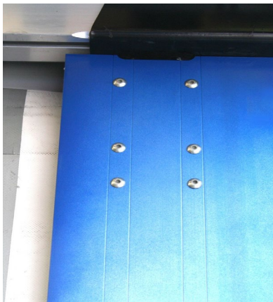
Tylne słupki narożne: sprawdzić trzymanie nitów
