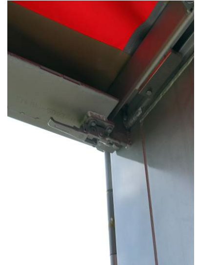
Zár a hátsó portálösszekötőnél: Csavarok rögzítettsége, hegesztésnél van-e repedés
