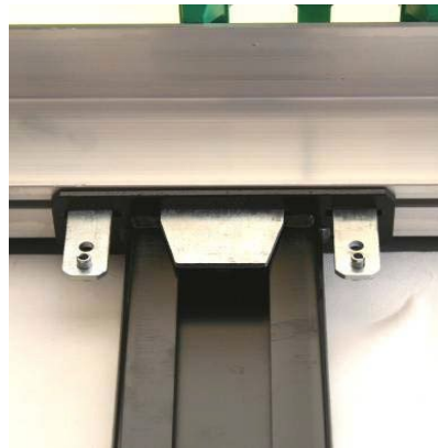
Középoszlopok futókocsija: szegecsek megfelelő rögzítettsége
