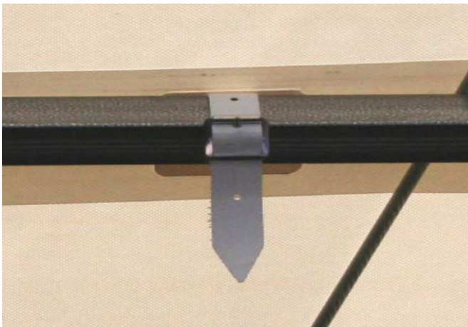
Feszítőszíjak ellenőrzése, van-e rajtuk sérülés
