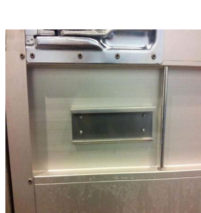
Quick-Slide-zár: szegecsek megfelelő rögzítettsége
