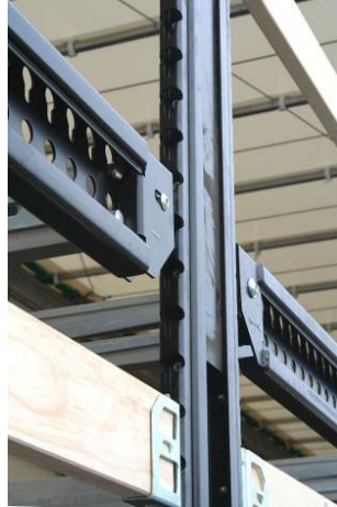
Középoszlopok oldalt: a sínek szegecsei megfelelően rögzítettek-e
