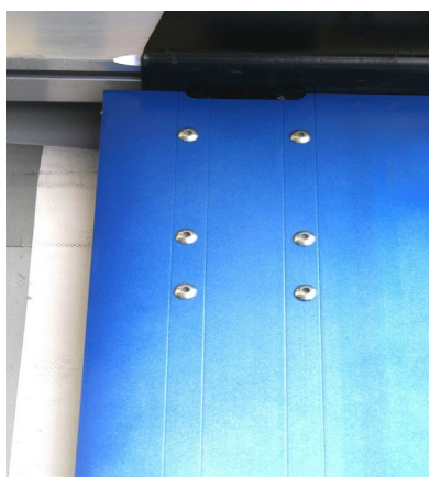
Hátsó sarokoszlopok: szegecsek megfelelő rögzítettsége
