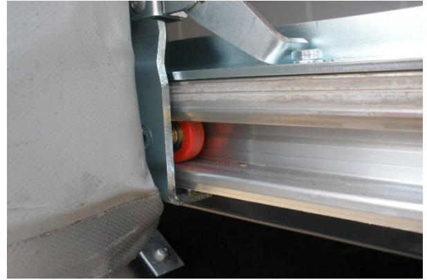
Alsó csuklók és futókocsik működését, kopottságukat ellenőrizni, csavarok rögzítettségét ellenőrizni
