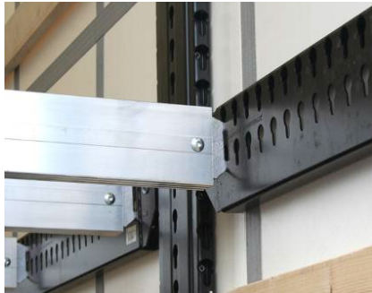
Gerendák: megfelelő állapotban vannak-e, ill. szegecsek megfelelő rögzítettsége
