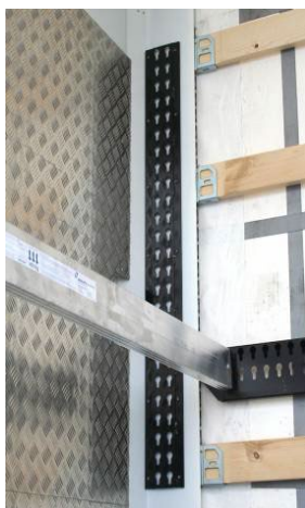
Rohové sloupky vpředu: zkontrolovat upevnění nýtů lišty.
