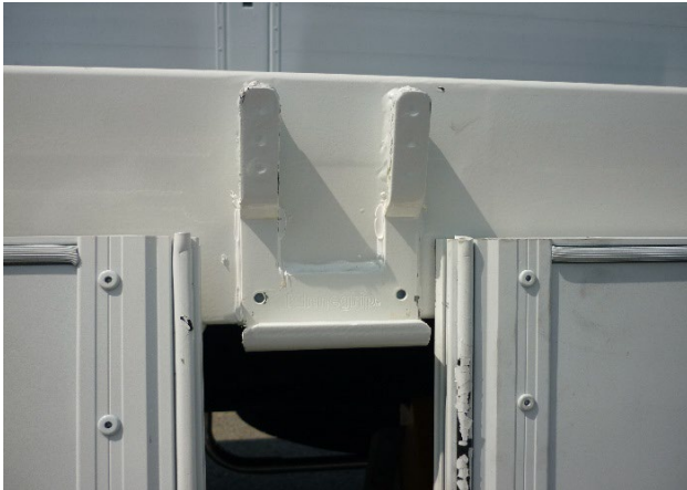
Uložení sloupků: zkontrolovat svary na praskliny.
