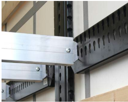
Nosné příčnický: zkontrolovat jejich řádný stav a zkontrolovat upevnění nýtů a šroubů.
