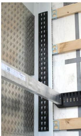
Rohové sloupky vpředu: zkontrolovat upevnění nýtů lišty.
