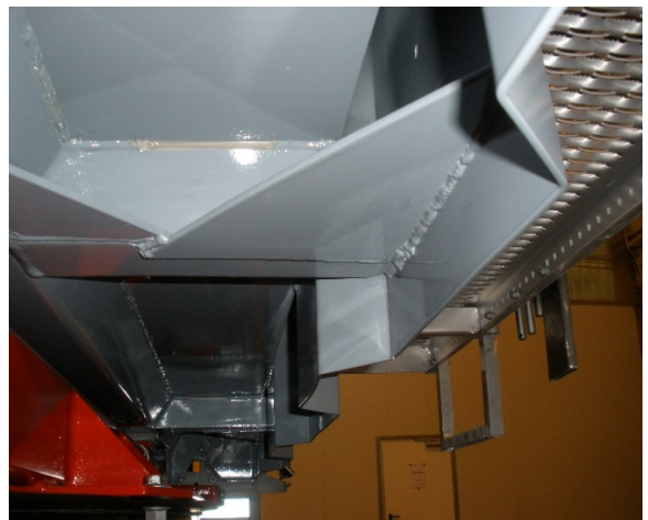
Schweißnähte auf Risse prüfen
