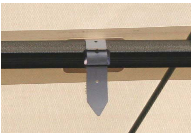
Spannriemen auf Beschädigungen prüfen
