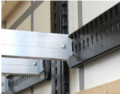
Tragbalken: Auf ordnungsgemäßen Zustand prüfen, Nieten auf Festsitz prüfen
