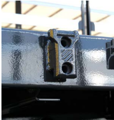
Rungenlager: Schweißnähte auf Risse prüfen
