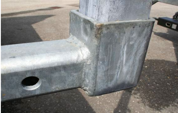
Wysuwane kłonicie: sprawdzić spoiny pod kątem pęknięć
