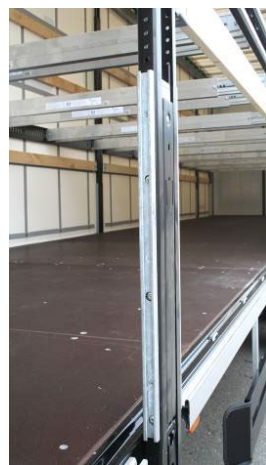
Środkowe słupki z boków na dole: sprawdzić trzymanie nitów
