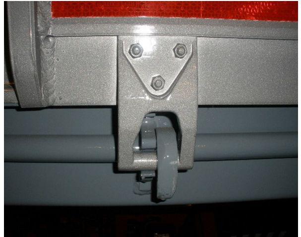
Zsanérok: hegesztési varratok ellenőrzése, van-e repedés, csavarok rögzítettségének ellenőrzése
