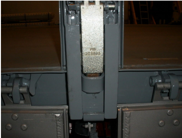
Oszlopzsánér: hegesztési varratok ellenőrzése, van-e repedés, mozgó alkatrészek kopottsága
