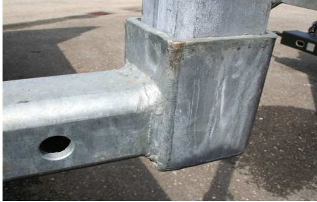
Kihúzható rakoncák: hegesztési varratoknál ellenőrizni, van-e rajta repedés
