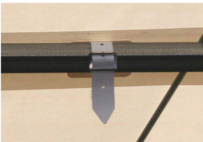
Feszítősíjak ellenőrzése, van-e rajtuk sérülés
