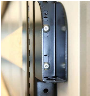
Léctartó zseb: ellenőrizni kell a szegecsek megfelelő rögzítettségét
