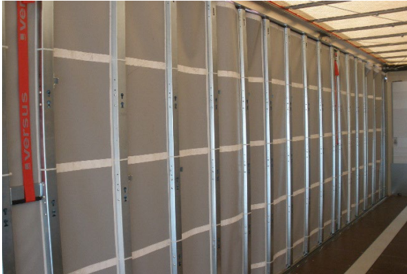
Quick Slider szemrevételeles ellenőrzése deformításra stb.
