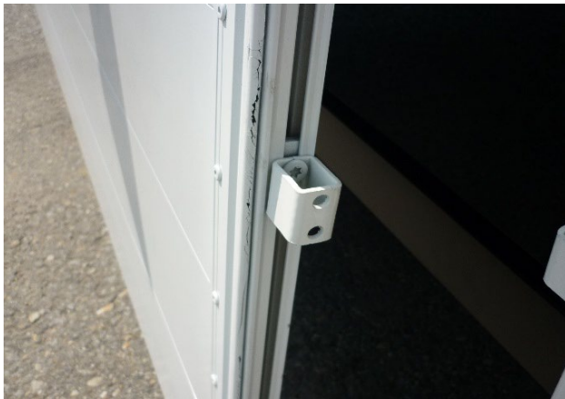
Zkontrolovat upevnění opěr a jejich stav.
