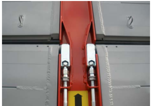
Bordwände innen und außen: Schweißnähte auf Risse prüfen
