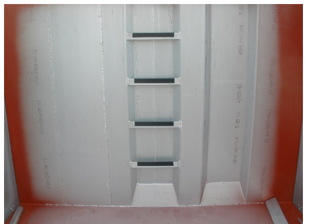
Innenseite: Schweißnähte auf Risse prüfen
