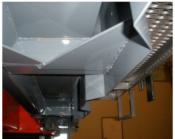
Schweißnähte auf Risse prüfen
